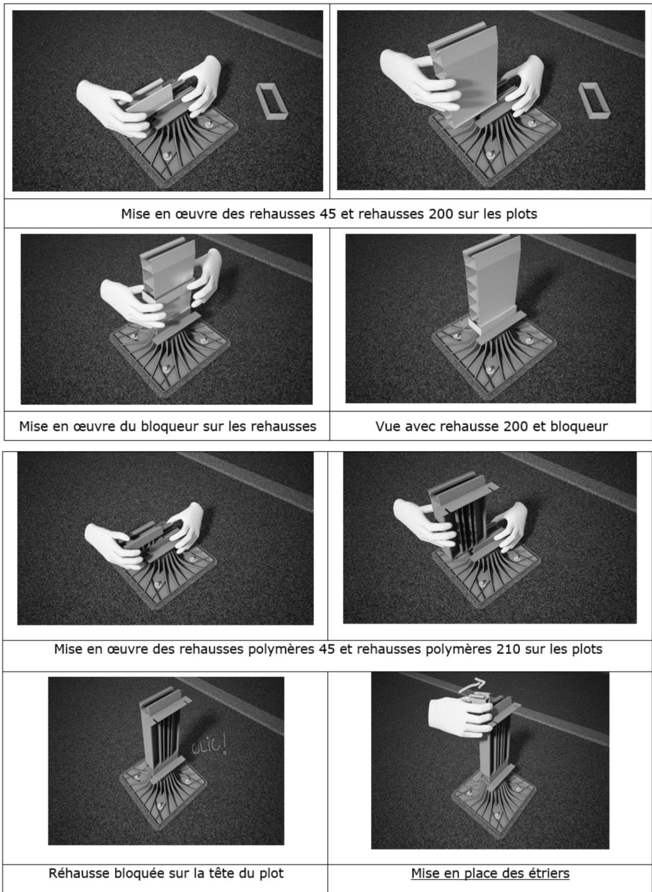
**Figure 26 : Mise en œuvre des rehausses et bloqueurs**
