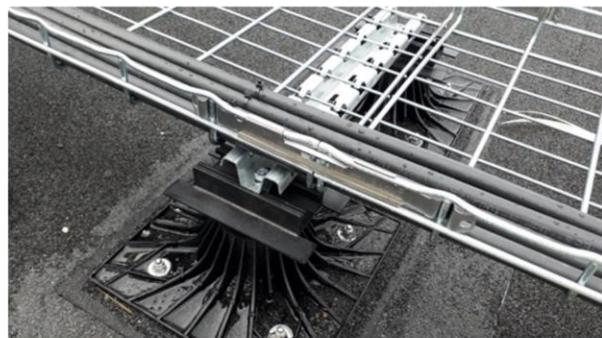
**Figure 15 : Supports de chemin de câble par oméga ou plots SOPRASOLAR FIX EVO**
