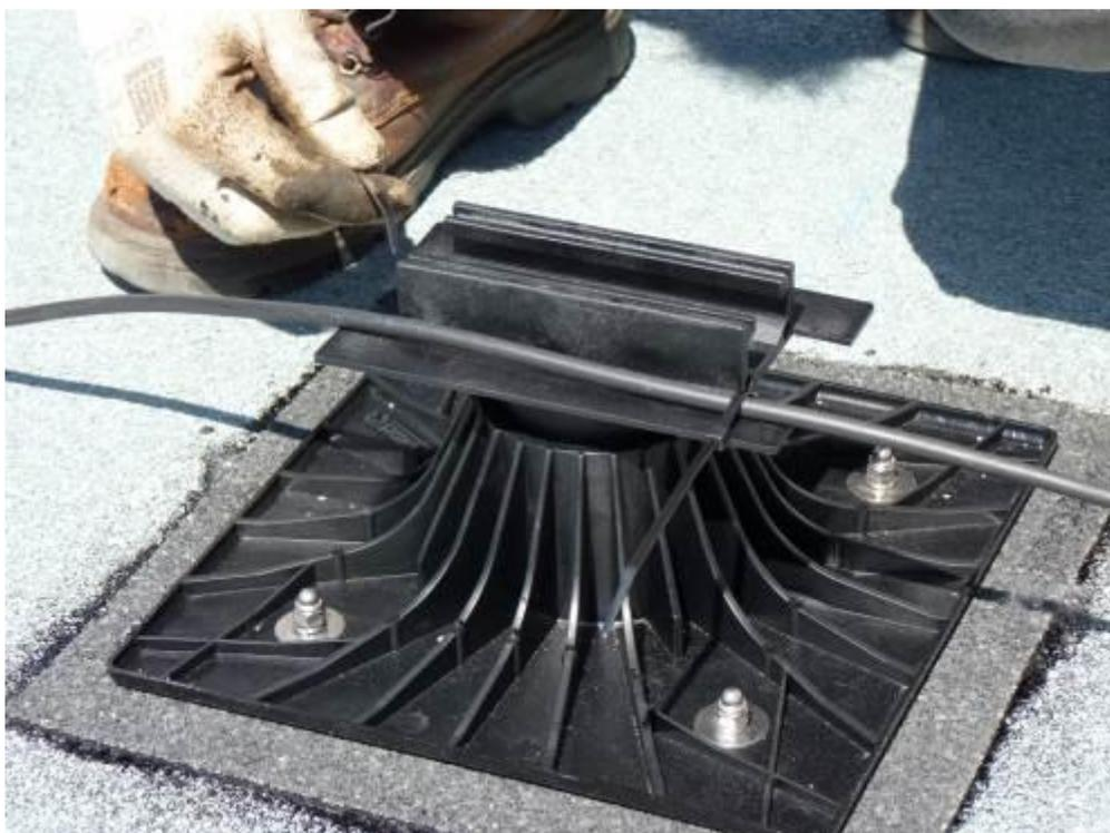
**Figure 22 : Mise en œuvre du revêtement d'étanchéité avec première couche SOPRAFIX HP et plaquette de répartition**
