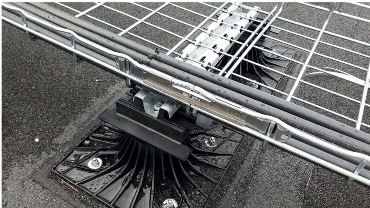
**Figure 16 : Supports de chemin de câble par oméga ou plots SOPRASOLAR FIX EVO**
