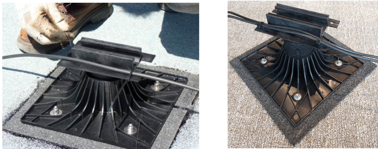
Figure 27 : Fixation câble électrique sur le plot standard à l'aide de collier Rislan et plot SOPRASOLAR FIX EVO -6- à l'aide d'un accessoire qui se fixe dans l'encoche de l'ailette
