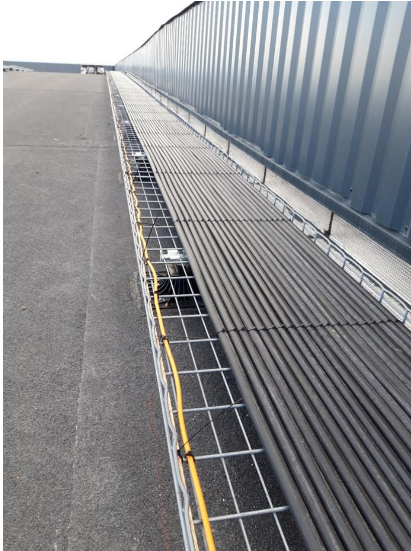
Figure 19 : Plots FIX EVO supports de chemin de câble
