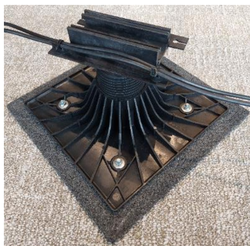
Figure 26 : Fixation câble électrique sur le plot à l'aide de Rislan ou à l'aide d'un accessoire type « pied sapin » dans les ailettes du plot '-6'
