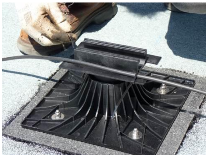
Figure 26 : Fixation câble électrique sur le plot à l'aide de Rislan ou à l'aide d'un accessoire type « pied sapin » dans les ailettes du plot '-6'
