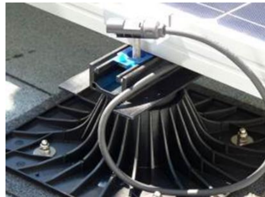
Figure 22 : Orientation de la tête du plot pour la pose du module photovoltaïque
