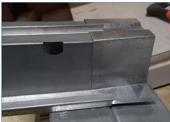
Figure 2 : insertion de l'éclisse sur le rail bas
