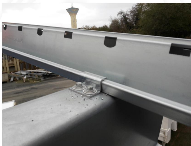
MISE EN ŒUVRE DU SOPRASOLAR CRAPAUD
