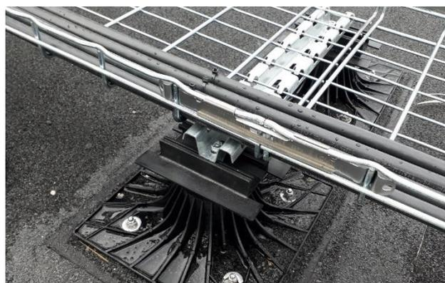
*Figure 15 : Plot SOPRASOLAR® FIX EVO utilisé comme support de chemin de câbles*
