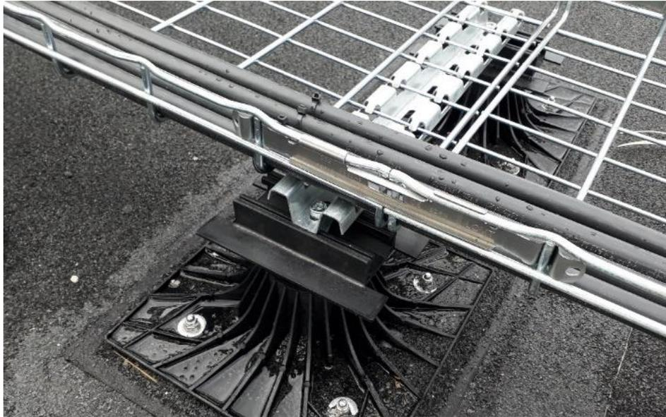
*Figure 14 : Plot SOPRASOLAR FIX EVO utilisé comme support de chemin de câbles*
