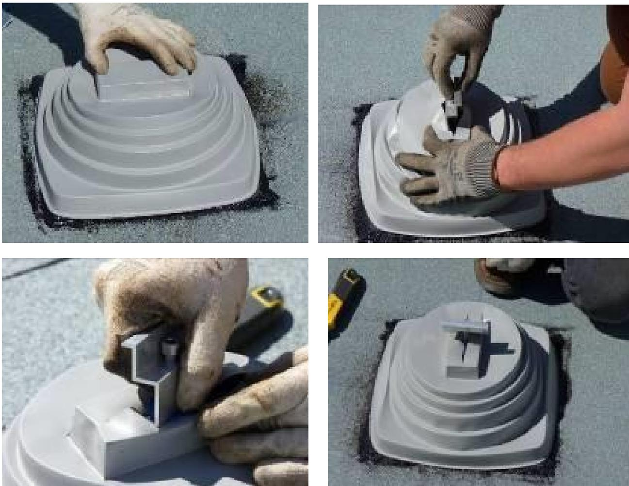
**Figure 39a : Mise en œuvre de l'étrier final sur le plot SOPRASOLAR FIX EVO couvert par un cache plot**
