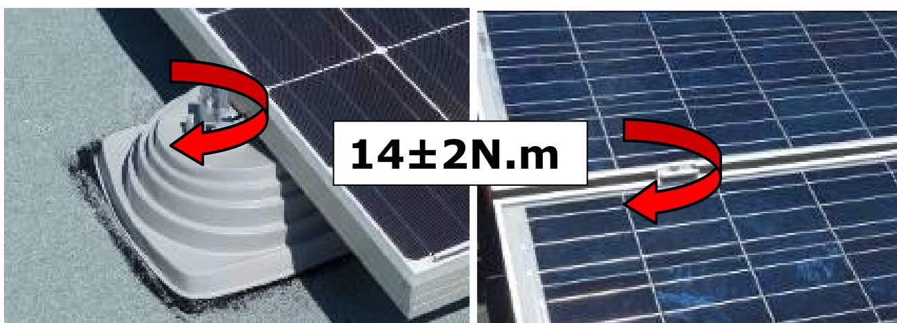
**Figure 39c : Mise en œuvre des modules photovoltaïques**
