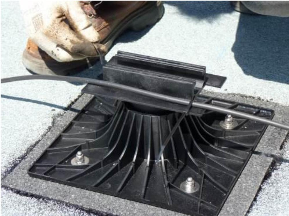
**Figure 16 : Implantation des plots SOPRASOLAR FIX EVO TILT avec modules photovoltaïques en inclinaison simple shed**
