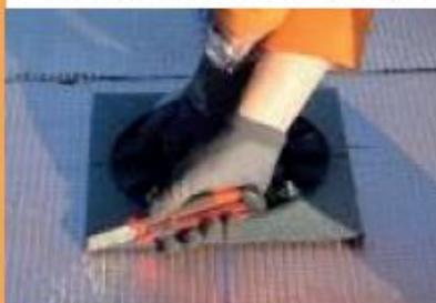
Tracer l'empreinte du plastron du plot en découpant la feuille aluminium de protection de la membrane apparente à l'aide d'un cutter pour repérer sa position sur le revêtement d'étanchéité
