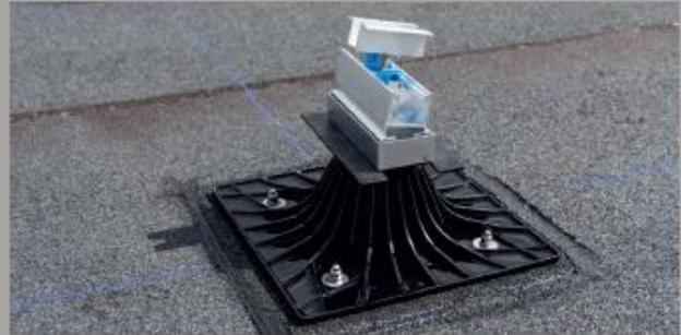
**b-** Mise en oeuvre du bloqueur pour éviter que la rehausse ne se déchausse de la tête du plot et insérer l'écrou cage du kit étrier dans la rehausse par l'ouverture prévue à cet effet.
