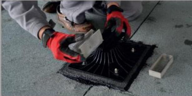
**a-** Pose de la rehausse en fonction du calepinage.
