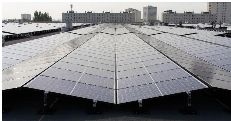
*Photo 1 : Vue du procédé SOPRASOLAR FIX EVO TILT avec modules photovoltaïques en mode portrait (orientation « EST/OUEST »)*
