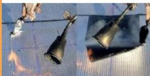
Délardage de la feuille d'aluminium à l'aide du chalumeau et d'une spatule la zone repérée
