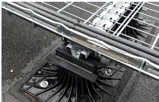
*Photo 4 : Plot SOPRASOLAR FIX EVO servant de support de chemin de câbles*
