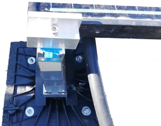
*Photo 8 : Etrier posé en limite de cadre*
