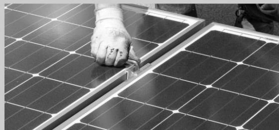
Vérouiller la position des modules en serrant les étriers sur les réhausses avec un couple de serrage de 14 N.m.
