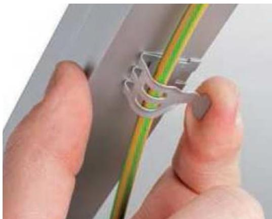
*Photo 3 : fixation des câbles sur le retour du cadre des modules PV*
