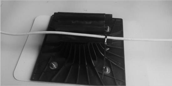
Les rallonges de câbles pour la connexion à l'onduleur doivent être fixées à l'aide de colliers de serrage sur le retour du cadre du panneau afin de réduire les effets de boucle induite. Les ailettes du plot peuvent être percées avec un forêt conique afin d'y faire passer un collier de serrage type Colson, qui permettra de serrer le câble qui reposera sur l'ailette. Cela évite le contact avec la membrane d'étanchéité et la possible stagnation d'eau autour des câbles et des connecteurs.
