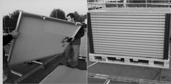
**IMPORTANT : Les modules doivent être mis en oeuvre selon le sens de pose préconisé par l'électricien du projet. Les modules ne doivent être fixés et raccordés qu'en présence d'un électricien habilité.**
