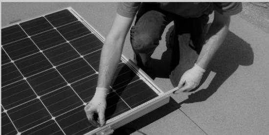
**IMPORTANT : Ne pas fixer les modules sur les plots tant que l'électricien n'a pas procédé à son raccordement avec les modules adjacents. Les modules doivent être fixés et raccordés uniquement par un électricien qualifié.**
