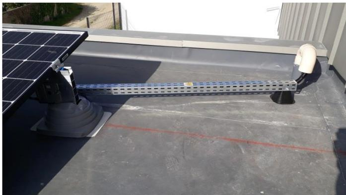
Cas de supports métalliques liaisonnés sur l'étanchéité: ce sont par exemple des omégas en tôles d'acier inox AISI 304 pliées de dimensions minimales 50mm x 50mm x 50mm x 150mm et d'épaisseur 1,2mm (voir Figure 32 au chapitre 14.4). Ces supports sont liaisonnés sur leurs deux côtés sur l'étanchéité à l'aide de bandes de membranes synthétiques soudées (voir Figure 33 au chapitre 14.4). La mise en place de ces supports doit être faite par l'étancheur.
