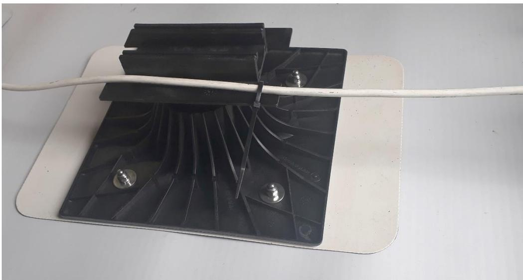
*Photo 2 : fixation des câbles sur les plots se trouvant sous les modules photovoltaïques*
