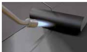
1- Mise en œuvre de l'étanchéité **SOPREMA** sous AT sur isolant de classe C minimum.
