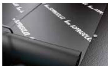
1- Pose 1ère couche d'étanchéité, **SOPRAFIX HP®**
