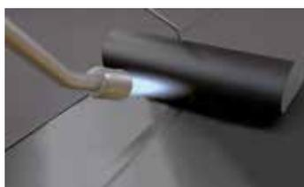
1- Mise en œuvre de l'étanchéité **SOPREMA** sous AT sur EFIGREEN ALU +.
