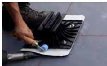
1- Soudure d'un côté du plastron sur 3cm de large minimum par thermosoudure sur une étanchéité FLAGON® SR ou FLAGON® EPPR.
