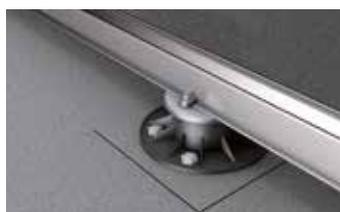
2.2- Pose des rails et des blocs rails.
