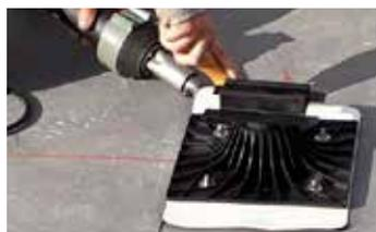
2- Soudure de l'autre côté du plastron sur 3cm de large minimum.
