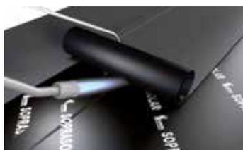
2- Pose de la 2ème couche d'étanchéité, **SOPRASOLAR® CAP**.
