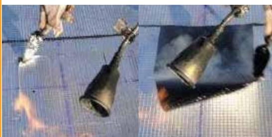
Délardage de la feuille d'aluminium à l'aide du chalumeau et d'une spatule la zone repérée
