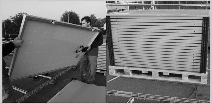
**IMPORTANT : Les modules doivent être mis en œuvre selon le sens de pose préconisé par l'électricien du projet. Les modules ne doivent être fixés et raccordés qu'en présence d'un électricien habilité.**
