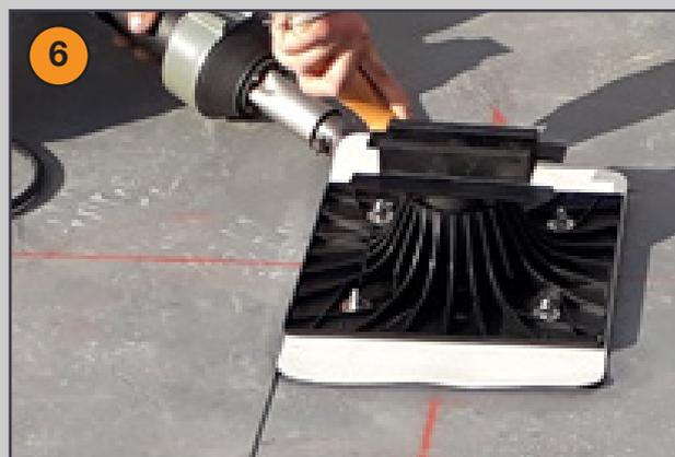
6 Soudure de l'autre côté du plastron sur 3 cm de largeur minimum
