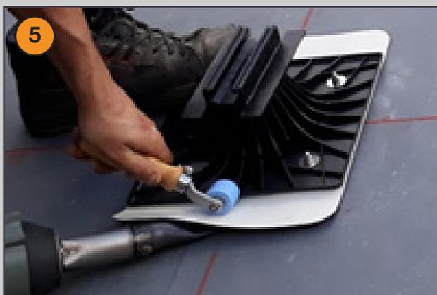
5 Soudure d'un côté du plastron sur 3 cm de largeur minimum
