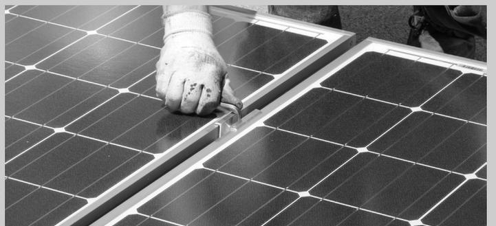
Verrouiller la position des modules en serrant les étriers sur les réhausses avec un couple de serrage de 14 N.m.
