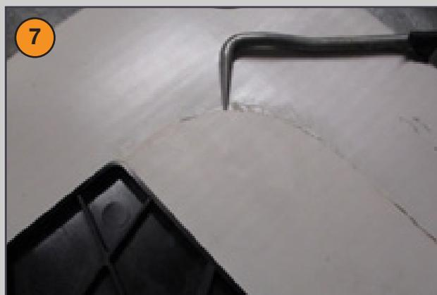
7 Après refroidissement, vérification de la qualité des soudures à l'aide du testeur.
