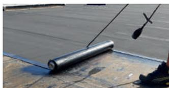
**1-** Mise en œuvre du complexe d'étanchéité, avec le SOPRASOLAR® Cap en deuxième couche.
