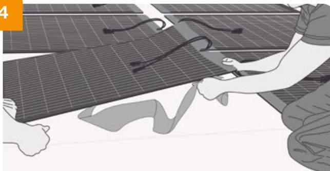
→ Retirer le film de protection du butyle de l'autre côté et coller le module.
