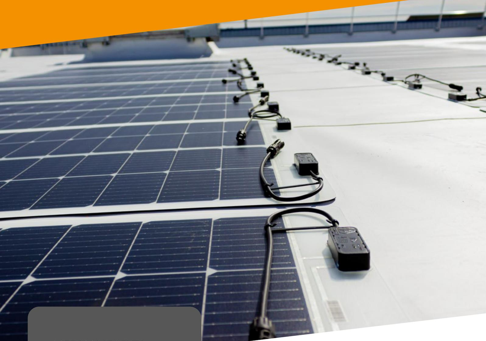
**SOPRASOLAR® FLEX TPO ATEx** est un procédé d'étanchéité photovoltaïque pour toiture terrasse avec membrane d'étanchéité synthétique en TPO et mise en place de modules photovoltaïques souples ou semi-rigides.
