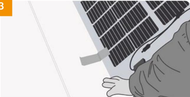
→ Mettre le module photovoltaïque sur la tranche en veillant à ce qu'il ne se déplace pas.
