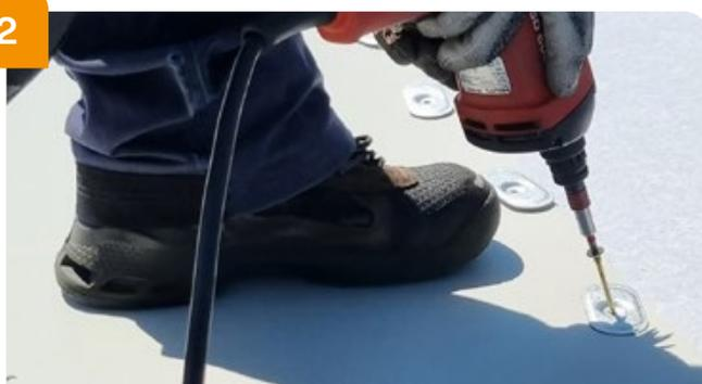
➔ Fixer mécaniquement la membrane (vis penchée pour tendre la membrane dans le sens transversal).
