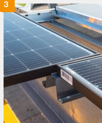
Pose des modules sur les rails.
