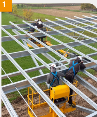
Mise en place des rails Soprasolar® Park.
