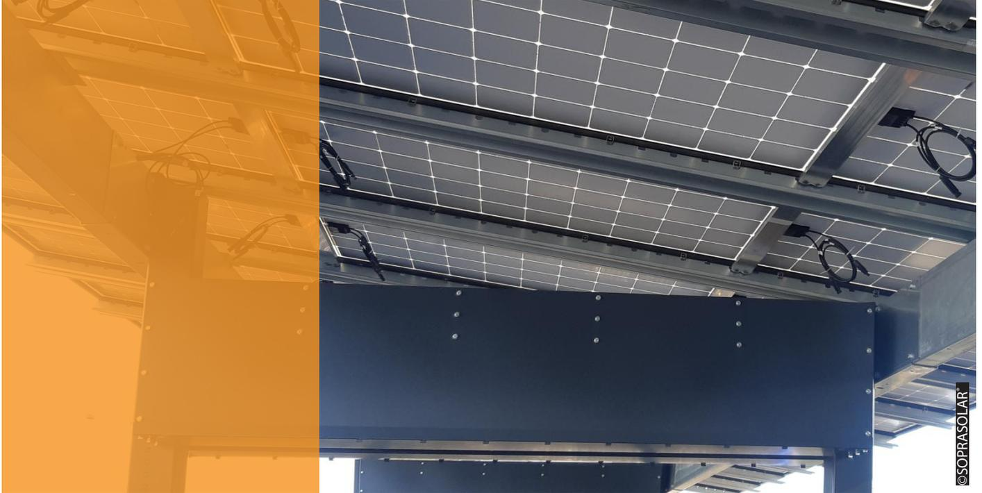
1. Intercaler une gouttière inter-module entre chaque module pendant la mise en œuvre de ceux-ci.
