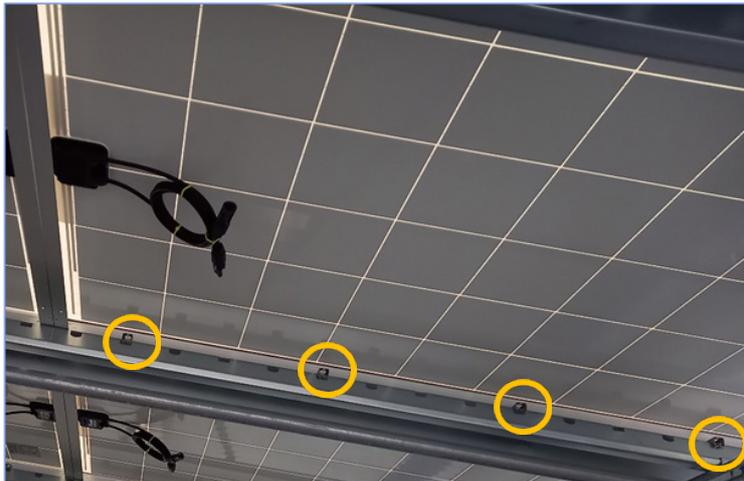
c- Enfoncer le clip de fixation au maillet jusqu'à sa mise en butée ;
