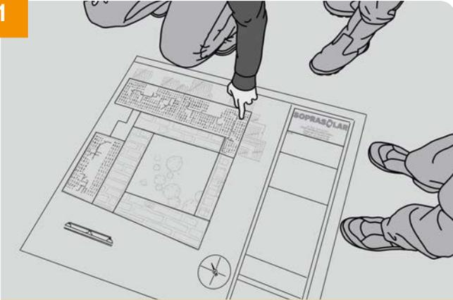
→ Vérifier les côtes de la toiture et l'emplacement des émergences par rapport au PLAN D'EXÉCUTION avant tout traçage.
