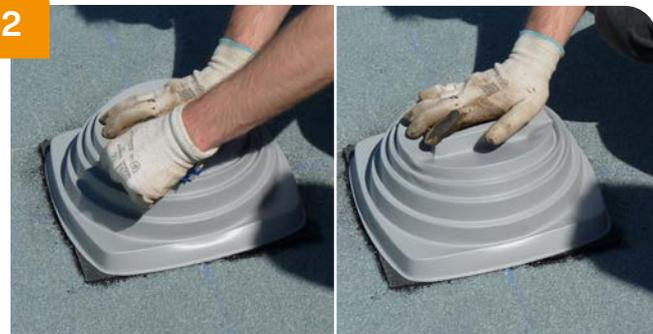
→ Appuyer sur le cache-plot par sa tête afin de l'adapter à la hauteur du plot.
