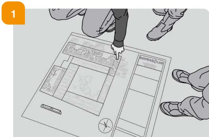
→ Vérifier les cotes de la toiture et l'emplacement des émergences par rapport au PLAN D'EXÉCUTION avant tout traçage.
