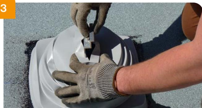
→ Insérer l'étrier dans la potence du plot par l'ouverture prévue à cet effet dans le cache-plot.
