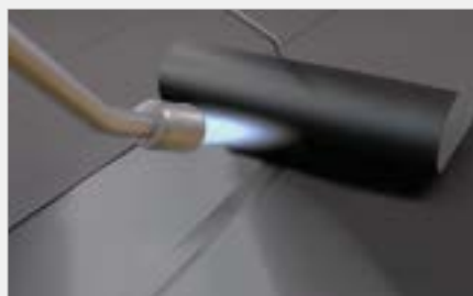
1 - Mise en œuvre de l'étanchéité SOPREMA sous AT sur isolant de classe C minimum.
