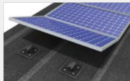
3 - Pose des modules, des étriers et raccordement électrique à l'avancement.
