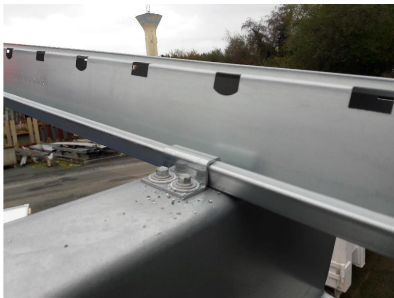
MISE EN OEUVRE DU CRAPAUD SOPRASOLAR PARK
